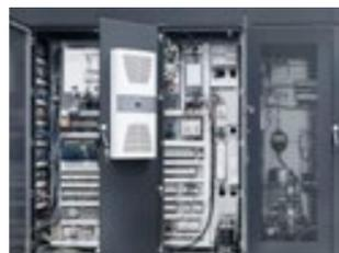
Klimatisierter Elektroschrank isoliert von Wärmequellen, mit einfachem Zugang.
